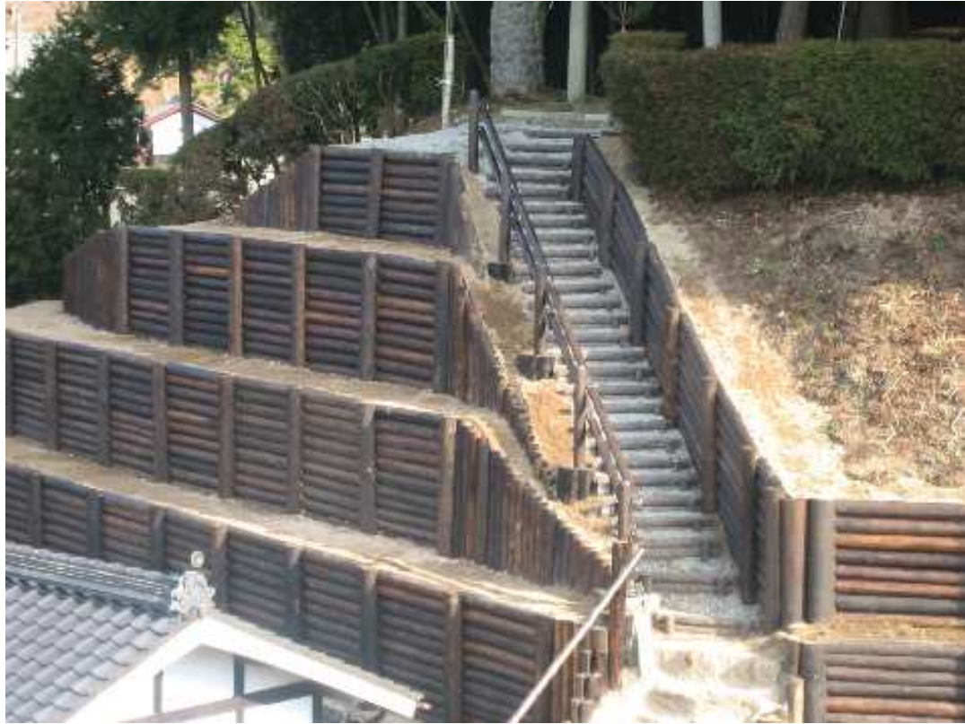
崩れた斜面をフォレストベンチ工法で改修した事例
